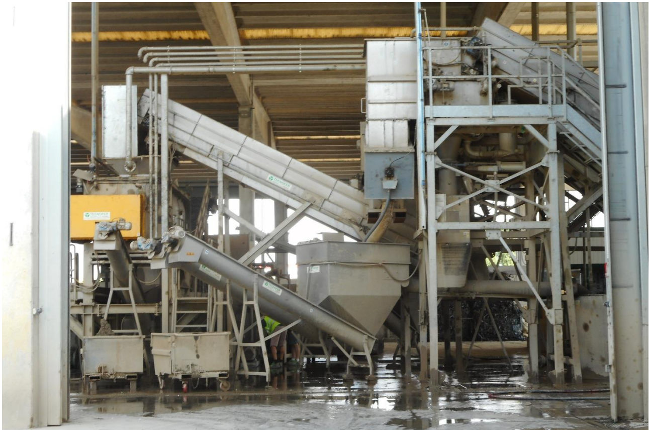
Figura 9-4 - Impianto recupero plastiche
