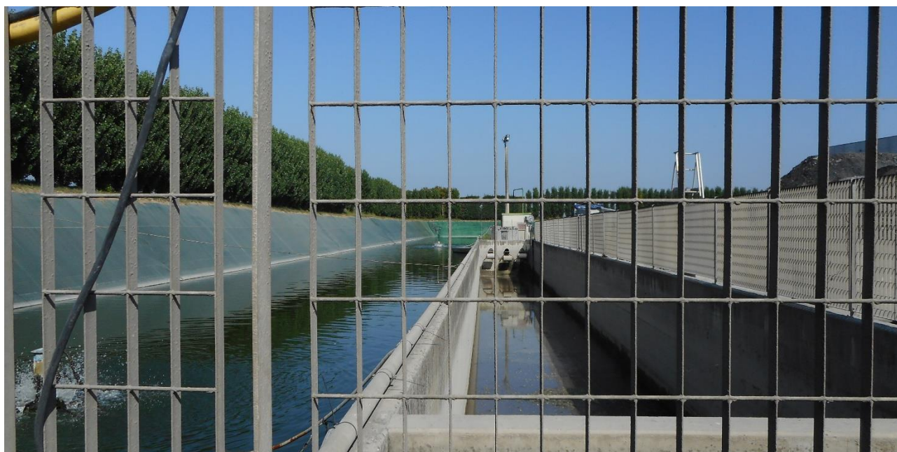
Figura 8-5 – Impianto acque meteoriche gestito dal Consorzio Cerea S.p.A.
