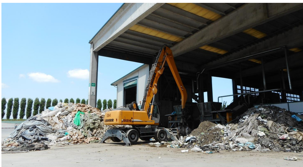
Figura 8-4 - Impianto recupero plastiche
