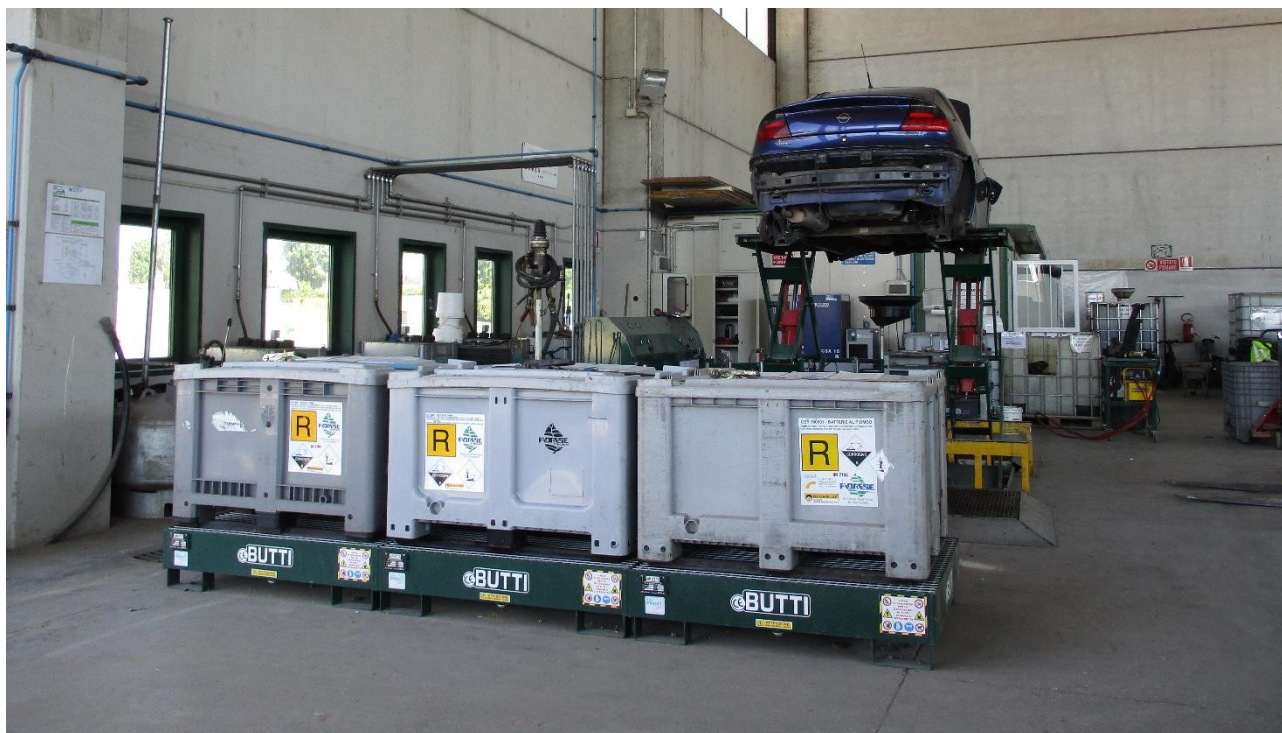
Figura 5-2 - Impianto di bonifica veicoli fuori uso - Agosto 2016
